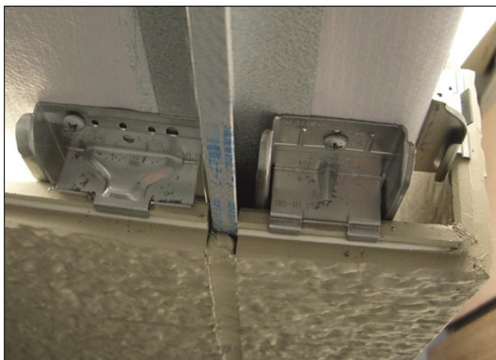
Устройство вертикального шва между панелями
