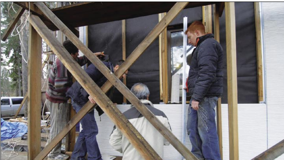
Монтаж облицовки на деревянную подконструкцию
