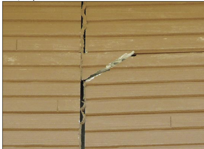
Деформация и разрушение облицовки
