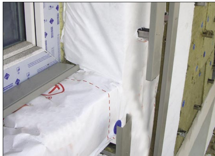
Комплекс таунхаусов в Куркино «Теплый дом». Толщина утеплителя – 300 мм
