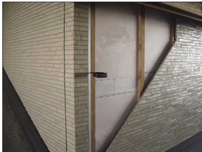
Фрагмент облицовки фиброцементным сайдингом на деревянную подконструкцию
