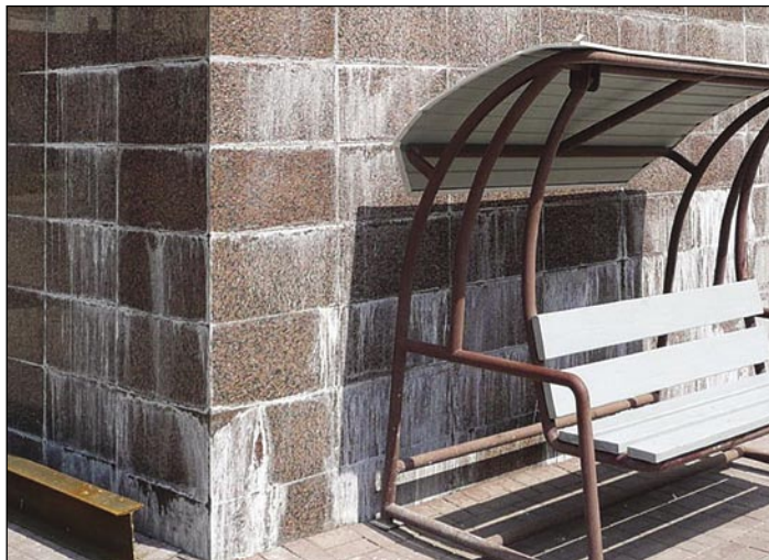
Высолы на фасаде при «мокроем» способе установки облицовки
