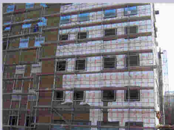
Рис. 1. Реконструируемое здание в Москве с монтируемым фасадом и алюминиевой подконструкцией
