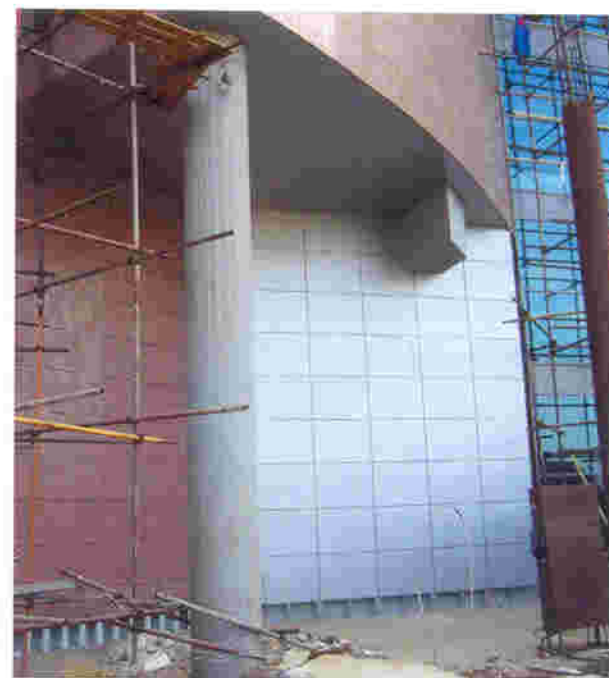
Рис. 9. Фасадная система с облицовочными элементами из композитного материала с отсутствующими зазорами между облицовочными элементами и с горизонтальным участком воздушного зазора
