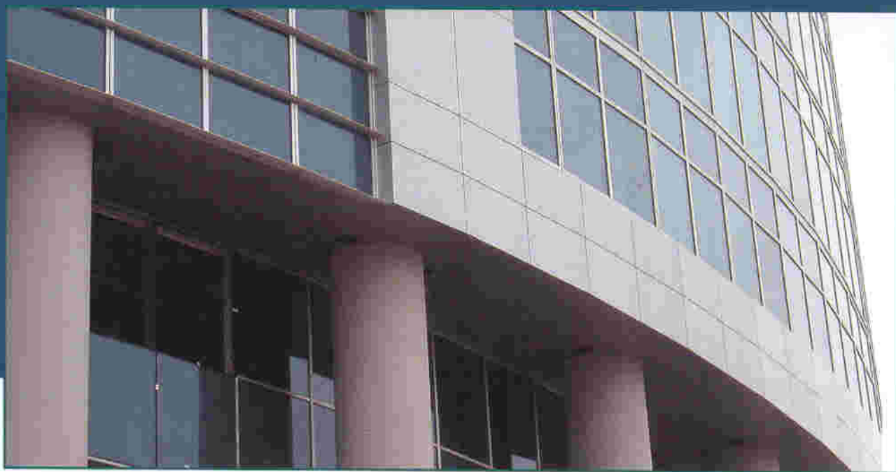
Фасадная система с облицовочными элементами из композитного материала с отсутствующими зазорами между облицовочными элементами и с отсутствующим входом в воздушный зазор
