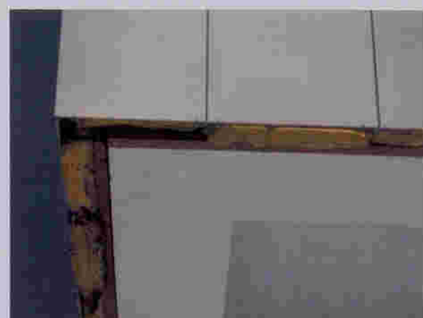
Рис. 3. Отсутствие воздушного зазора (вид снизу)
