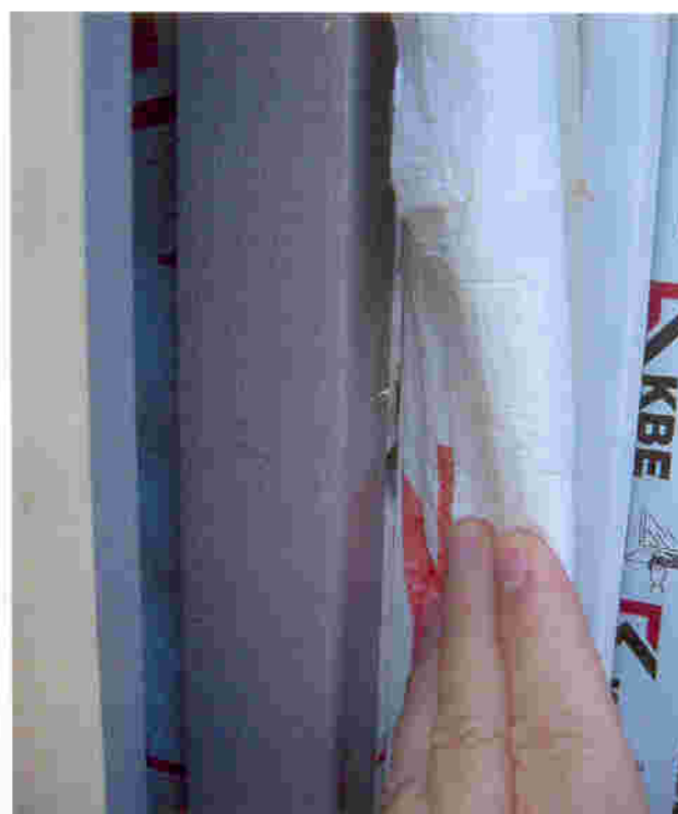
Рис. 12. Установка оконного блока с обрамлением по откосу стальным профилем, с последующим его утеплением
