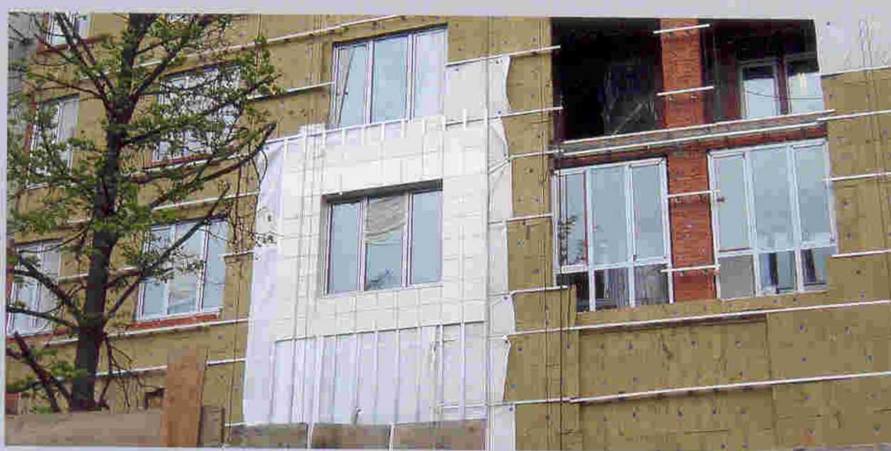
Рис. 6. Гидроветрозащитная пленка расположена поверх горизонтальных направляющих
