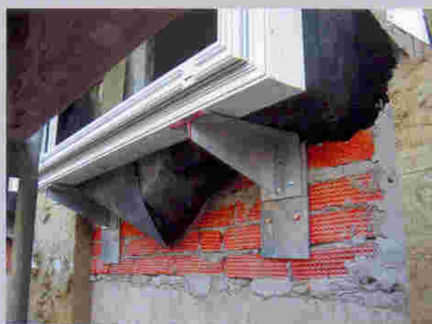
Рис. 2. Опираение витража
