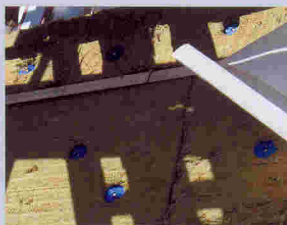
Рис. 4. Направляющая в виде алюминиевого уголка «утоплена» в слой минераловатного утеплителя
