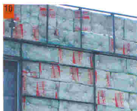
10. Произвольная замена влаговетрозащитной пленки 11. Неправильно решен узел сопряжения фасадной системы и цоколя 12. Не выдержано расстояние от края плиты до места расположения самореза
