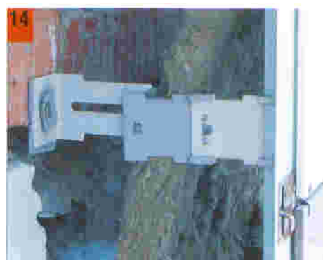
13. Отсутствие кляммера 14. Наглядный пример того, как при недостатке профессионализма приходится на выручку «солдатская смекалка» в месте крепления плитки с вырезом 15. Неправильная стыковка плит
