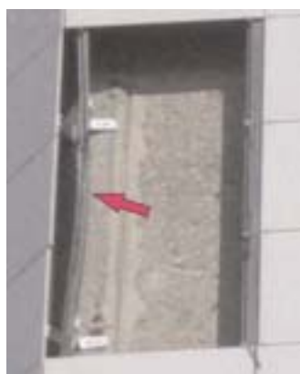
Рис. 6. Отсутствие температурных разрывов привело к деформации направляющих и выпадению плит на 7 этаже офисного здания.
