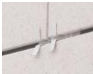
Рис. 2. Отсутствие зазора между кляммером и плитой облицовки приводит к отгибу лепестков кляммера в результате температурных деформаций направляющей.
