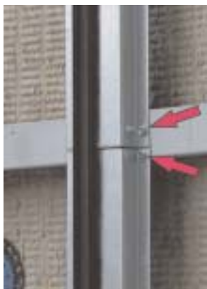
Рис. 5. Жесткое крепление стыка направляющих исключает компенсацию температурных деформаций.
