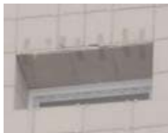
Рис. 4. Попытка устранения последствий неправильного монтажа откосов из керамического гранита при помощи клейкой ленты.
