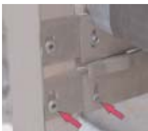
Рис. 3. Нестандартный способ борьбы с кривыми стенами путем наклеивания дополнительного кронштейна. Неправильное расположение клепки.
