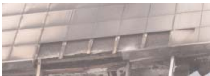
Рис. 7. Невыполнение в процессе монтажа НВФ обязательных противопожарных мероприятий привело к обрушению плит облицовки во время пожара.
