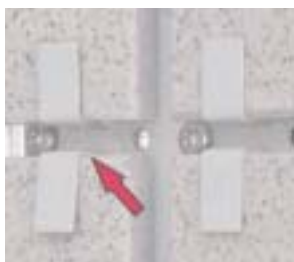
Рис. 2. Отсутствие зазора между кляммером и плитой облицовки приводит к отгибу лепестков кляммера в результате температурных деформаций направляющей.
