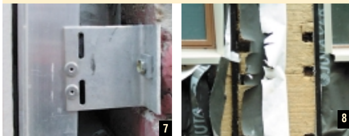
Рис. 7. В результате неправильной установки заклепок невозможна компенсация температурных деформаций направляющей. Причина — кривизна стены. Рис. 8. Демонтаж кронштейнов. Причина — неправильный выбор типоразмера кронштейна.
