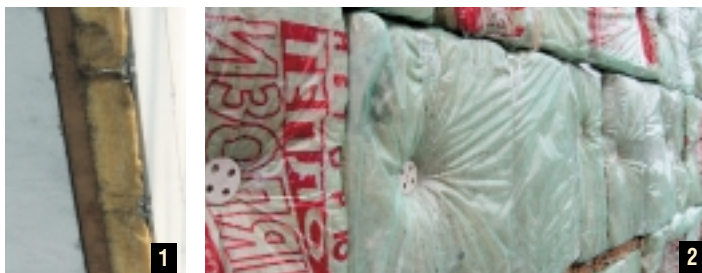
Отсутствие воздушного зазора (рис. 1) и использование полиэтиленовой пленки вместо ветрозащитной мембраны (рис. 2) приведет к переувлажнению и разрушению утеплителя.
