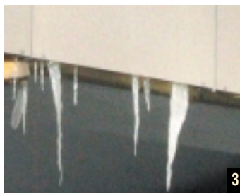
Рис. 3. Одно из следствий отсутствия воздушного зазора.
