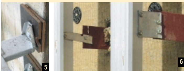
Рис. 5 и 6. Неверные способы компенсации кривизны стен по типу «сделал сам».
